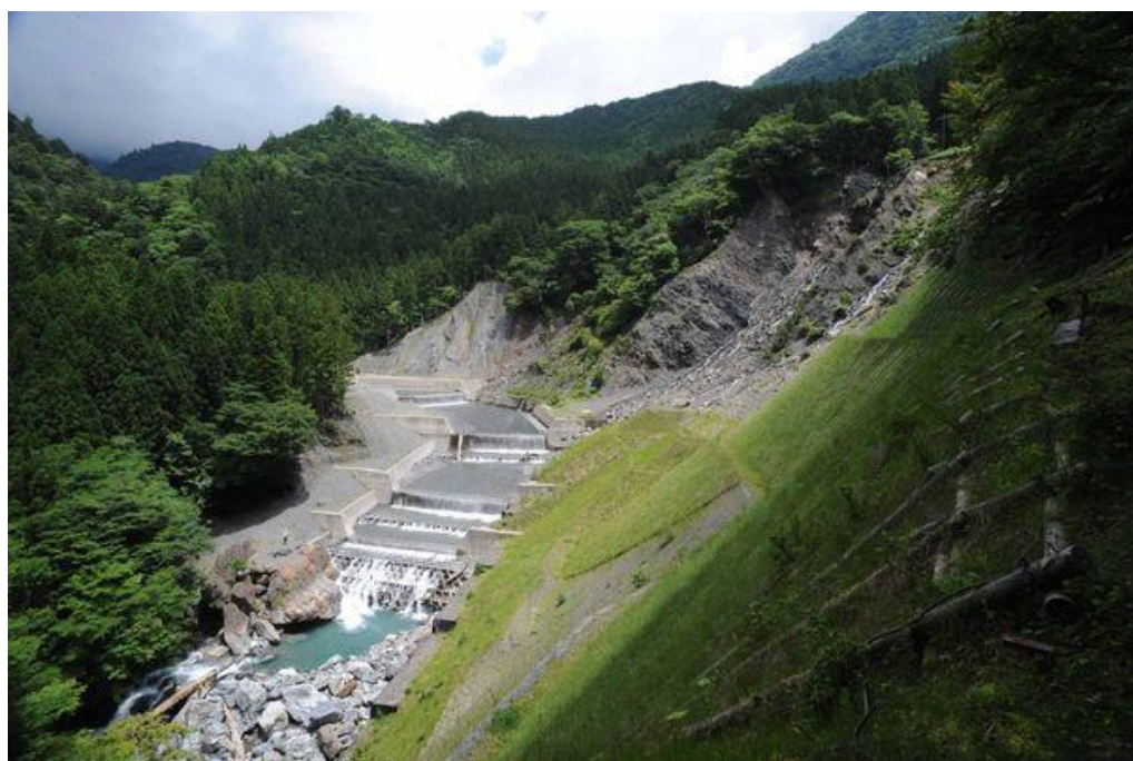
写真 西熊溪谷 連続砂防ダム
