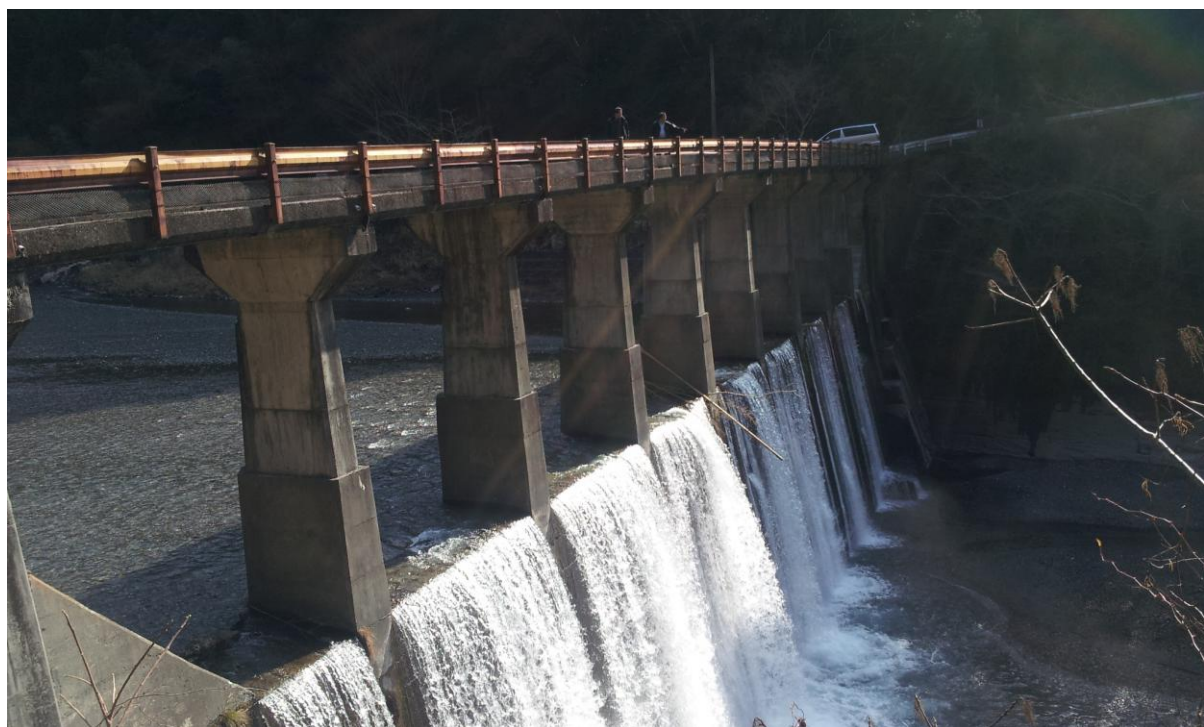
写真 安丸砂防ダム
