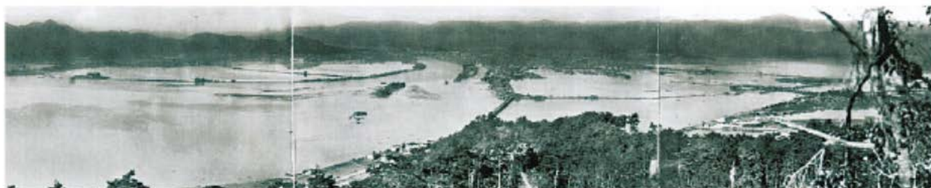
昭和の南海地震後 (地盤沈下が1.15m)
